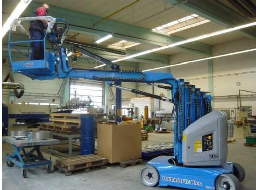
Der Austausch der Leuchtkörper erfolgte mit einer mobilen Hebebühne, so dass die laufende Produktion praktisch ungehindert weiterlaufen konnte.
