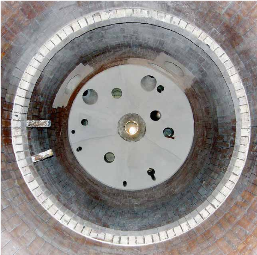
Blick in ausgemauerte Brennkammer
