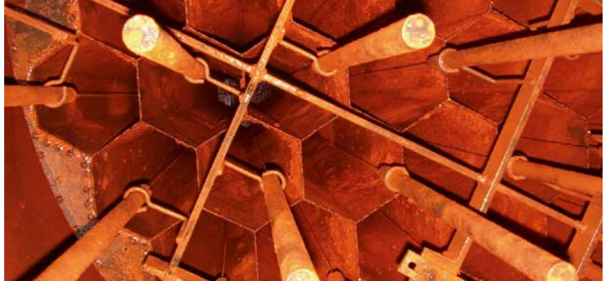
Waben eines Nasselektrofilters
