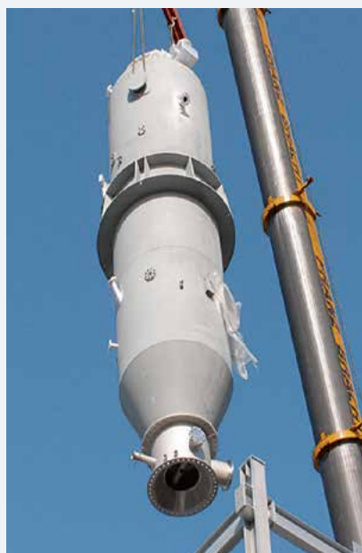
Montage einer beim Hersteller komplett vorausgemauerten Brennkammer mit angeflanschten Luft-Wasser-Quenchkopf
