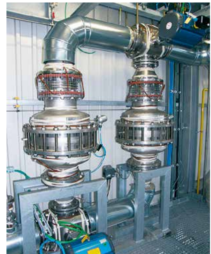
Detonationssicherungen zur Rückbrandsicherung bei Zone 1 Abgasen
