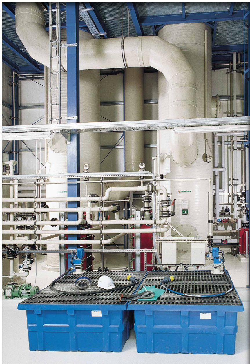
Ammoniak-Rückgewinnung durch Luftstrippung und saure Wäsche
