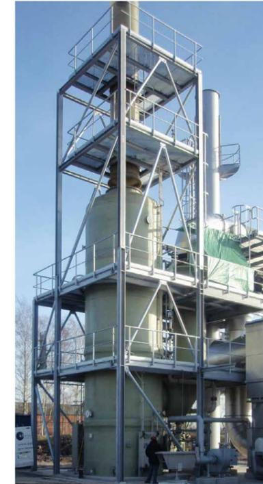
Einstufige Rauchgaswäsche nach regenerativer Nachverbrennung einer chemischen Produktion, 50.000 Nm<sup>3</sup>/h
