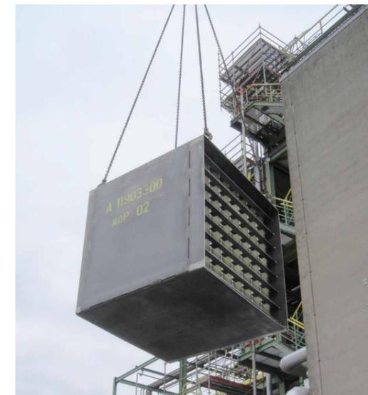
Montage eines Katalysatormoduls mit vormontierten Katalysatorwaben
