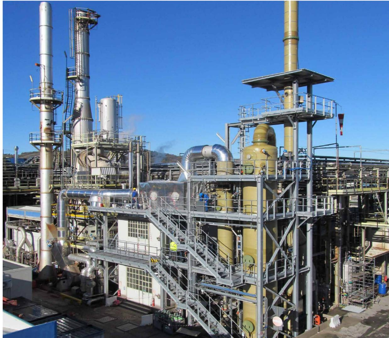
Rauchgaswäsche für 20.000 Nm<sup>3</sup>/h mit DeNOx-Katalysator, Heißgasquenche und mehrstufiger Absorption
